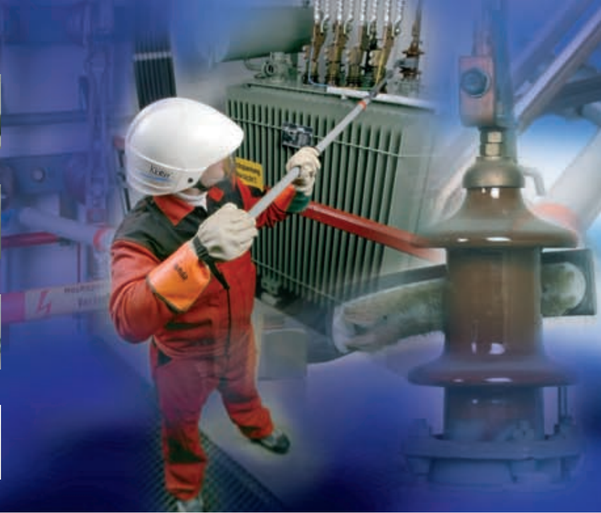
Reinigen des Schaltschlusses
