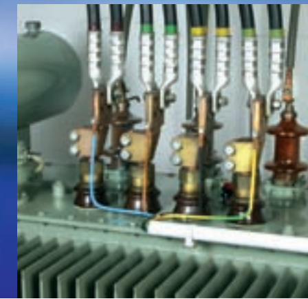
Transformator nach der Reinigung
