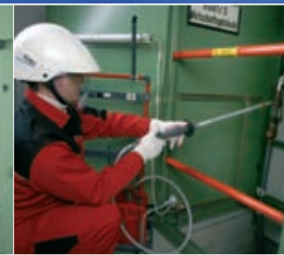
Befüllen des Endverschlusses unter Spannung
