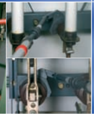
Feuchtreinigung Isolatoren
