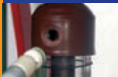
Lösen der Einfüllschraube am Endverschluss
