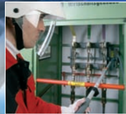
Reinigen des Schaltschlusses
