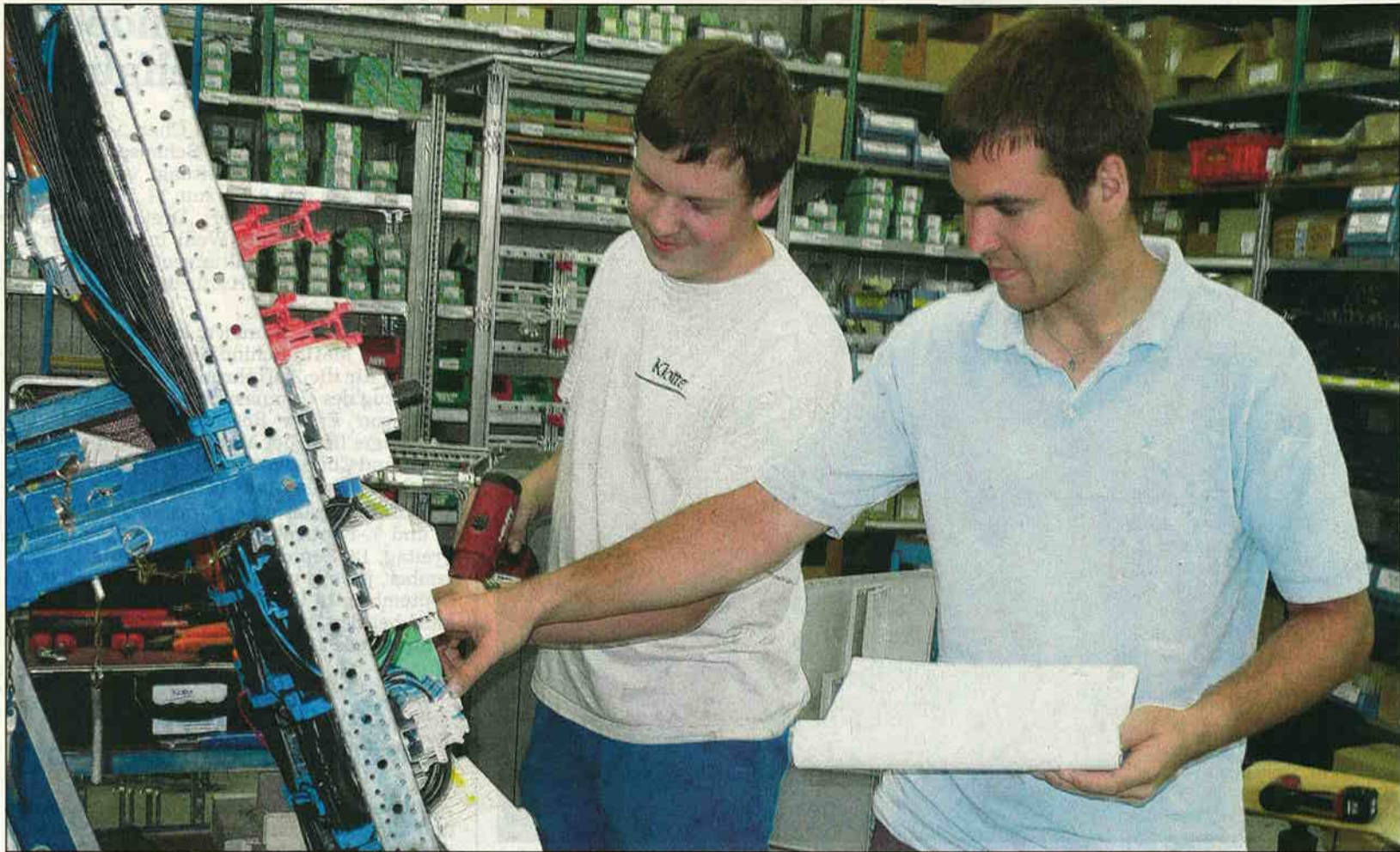
GUTE ZEITEN für den qualifizierten Nachwuchs: Im Bild zwei Lehrlinge der Firma Klotter beim Aufbau eines Installationsverteilers: Links Stefan Hauss aus Diersheim, rechts Markus Schmälzle aus Freistett. Foto: red
