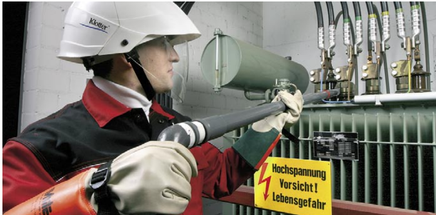
Unter Strom: Reinigung eines Öltransformators 20kV (li.). Rechts die beiden Geschäftsführer Roswitha Wiegert-Klotter und Werner Klotter.
